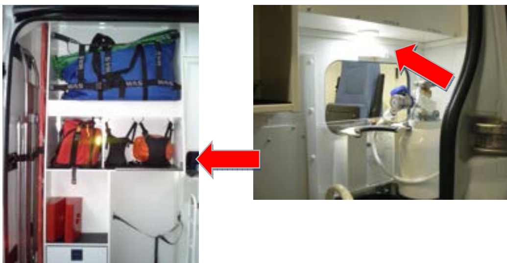
Rys. 34. Oświetlenie LED przedziału technicznego
