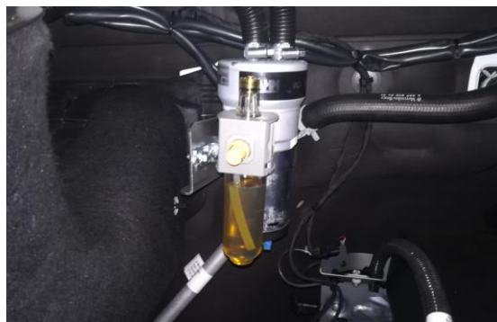
Rys. 15 Umieszczenie kompresora trąb Fiamm
