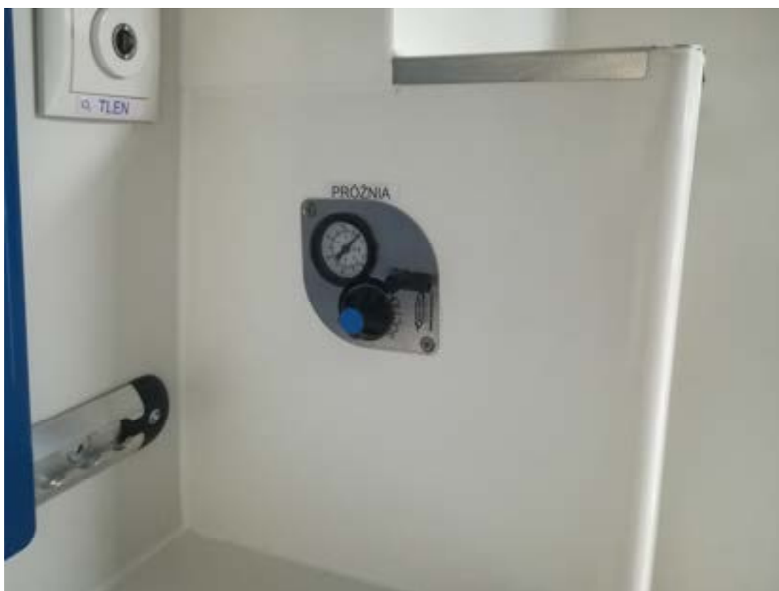
Rys. 37 Umieszczenie regulatora siły ssania
