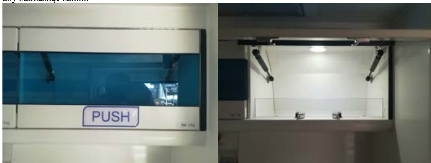
Rys. 44 System otwierania elementów meblowych „PUSH”.
