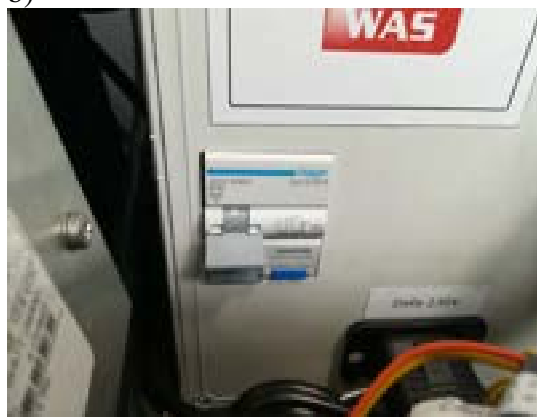
Rys. 12. a) wyłącznik różnicowo – prądowy w pozycji „WŁĄCZ” b) wyłącznik różnicowo – prądowy w pozycji „WYŁĄCZ”
