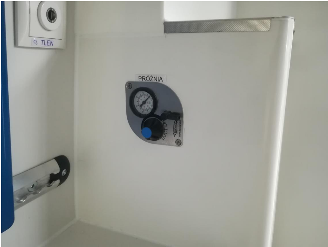
Rys. 37 Umiejscowienie regulatora siły ssania
