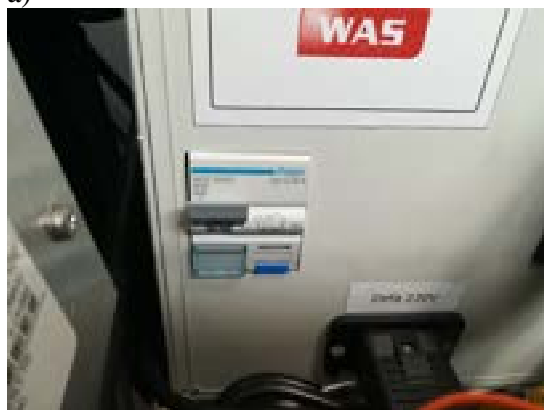
Rys. 12. a) wyłącznik różnicowo – prądowy w pozycji „WŁĄCZ” b) wyłącznik różnicowo – prądowy w pozycji „WYŁĄCZ”
