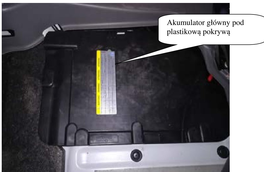
Rys. 6. Umieszczenie akumulatora głównego
