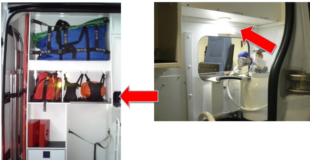
Rys. 34. Oświetlenie LED przedziału technicznego
