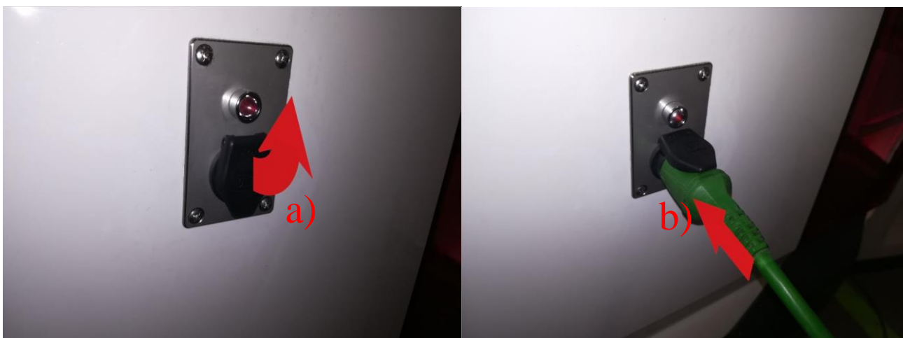
Rys. 5. Sposób podłączania zasilania do gniazda zewnętrznego. a) Unieść klapkę b) Podłączyć wtyczkę do gniazda.
